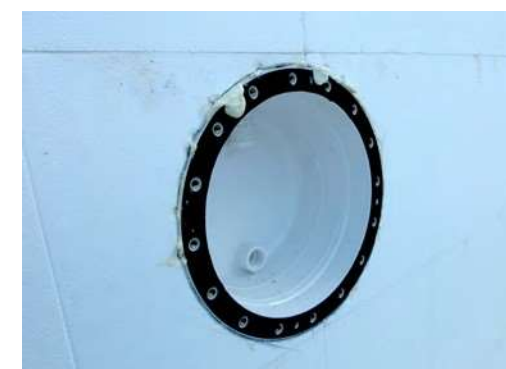
Kompletně zapěněné pouzdro reflektoru
