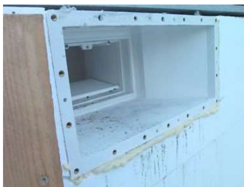
Kompletně zapěněný vstupní otvor skimmeru
