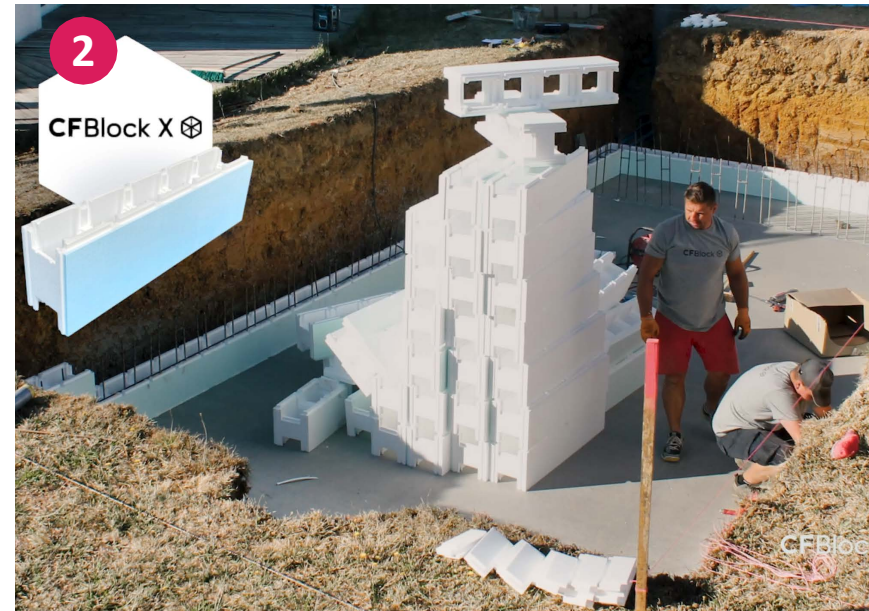
Usazení první řady polystyrenových bloků
