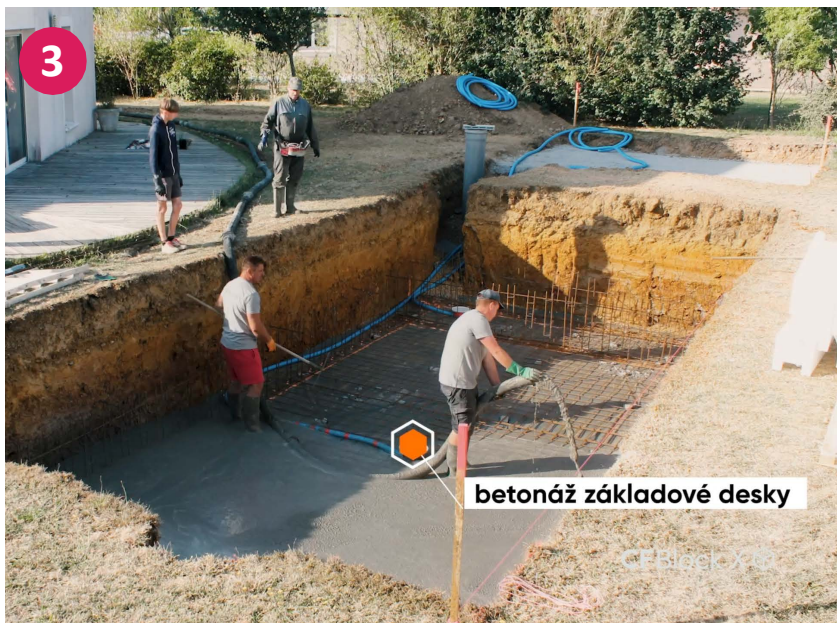
Uložení železa a betonu do obednění podlahové desky
