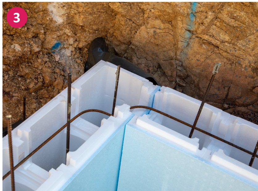
Detail rohového napojení včetně železné výztuže
