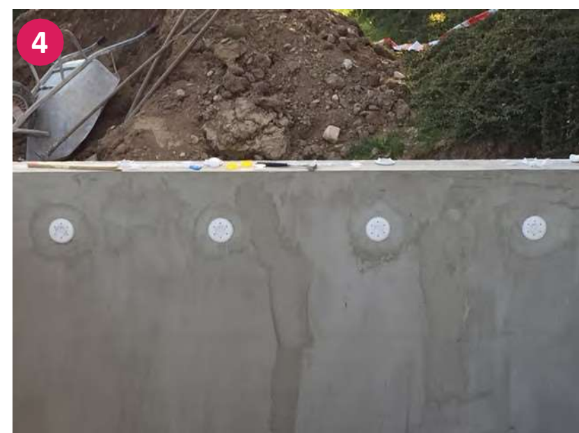
Důležité: před obsypáním bazénu natlačte potrubí a ověřte těsnost!
