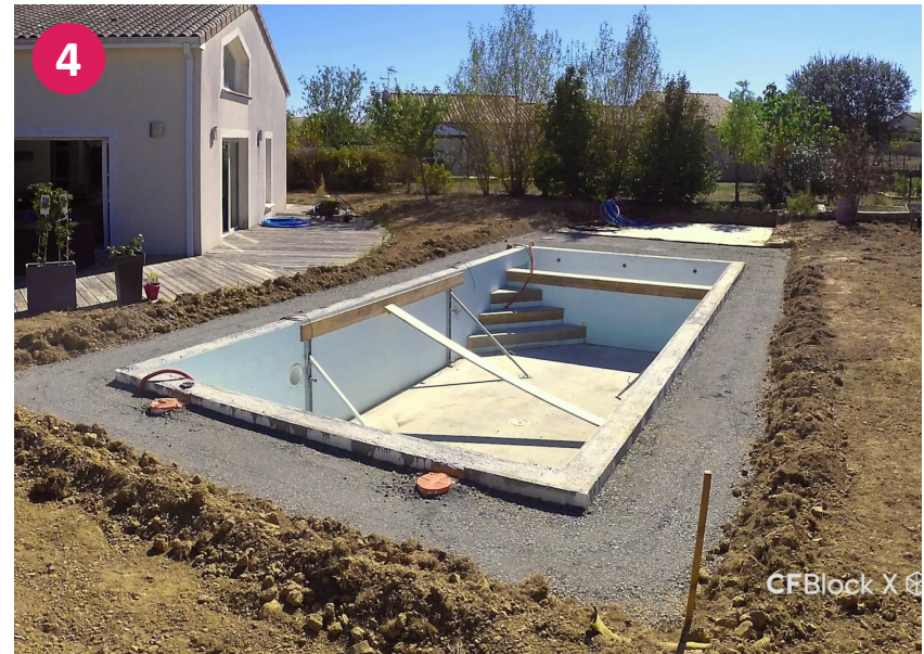
Zalítí polystyrenového bloku betonem
