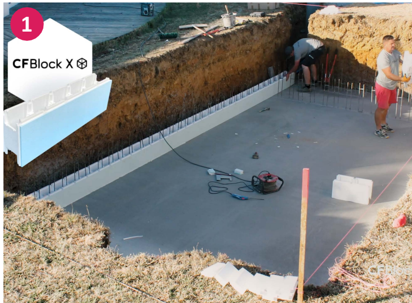
Kompletně vytvrzená základní deska
