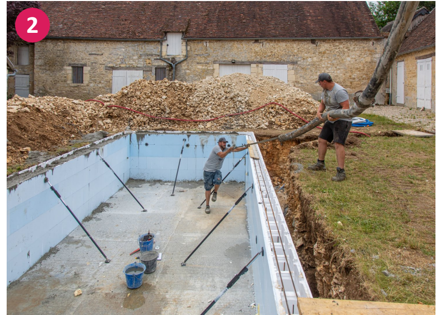
Zalítí polystyrenového bloku betonem
